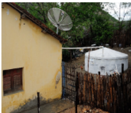
Imagem 1: reservatório de água
